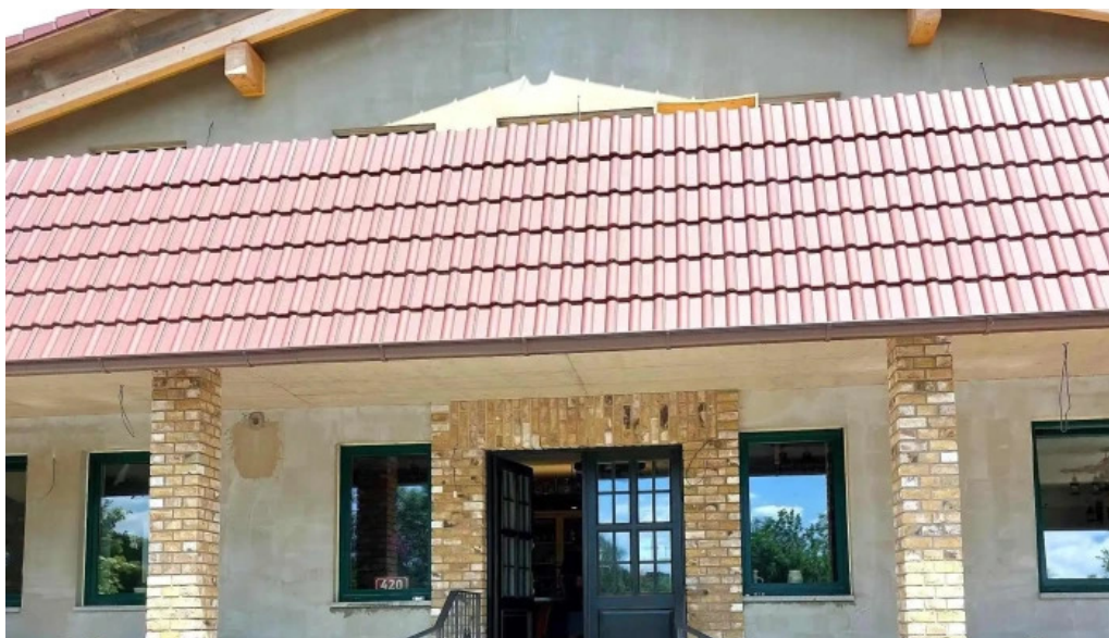
Restaurace u vorisku hledam
