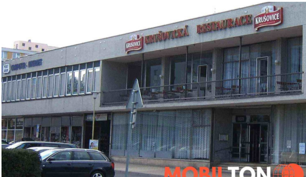
Krusovicka restaurace kladno vse
