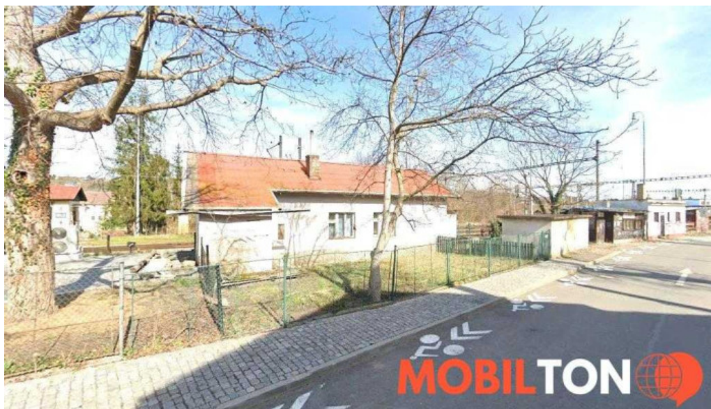
Revnice stavědlo 2 czech republic
