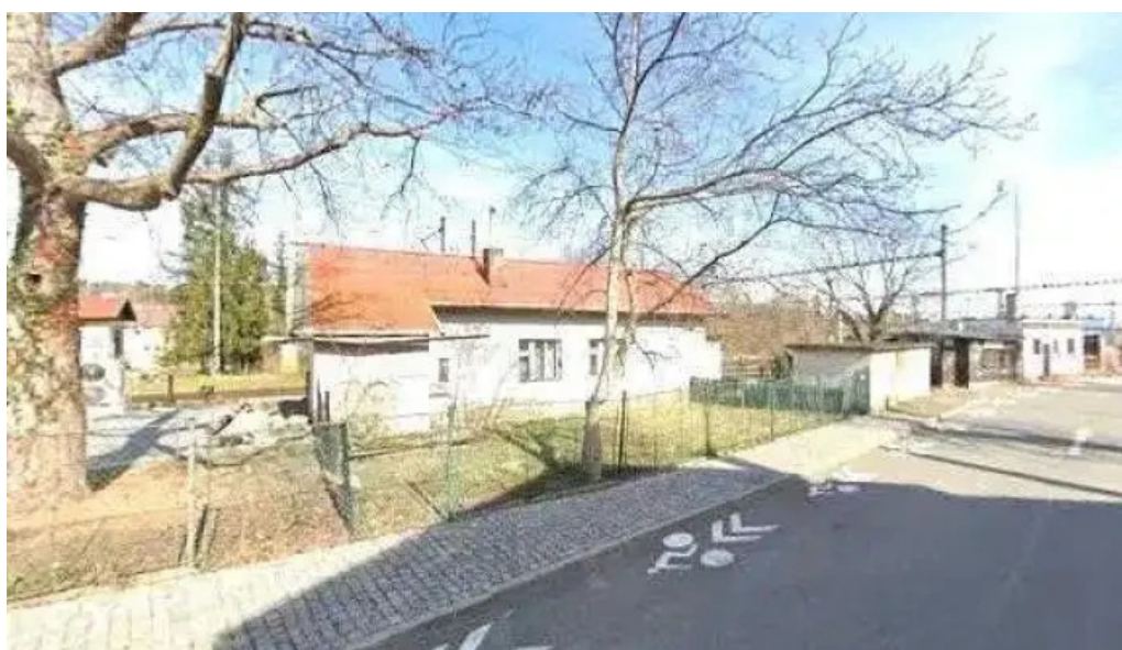
Revnice stavědlo 2 vse
