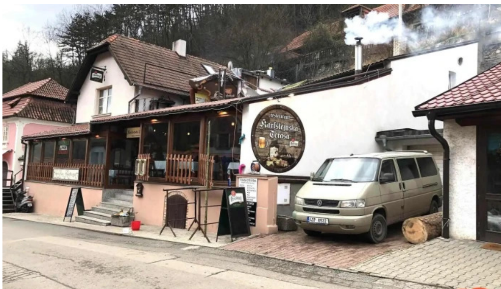
Karlstejska terasa restaurace buongiorno
