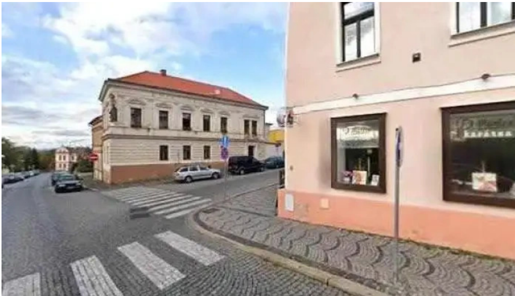
Casa de mateo street view a 360deg
