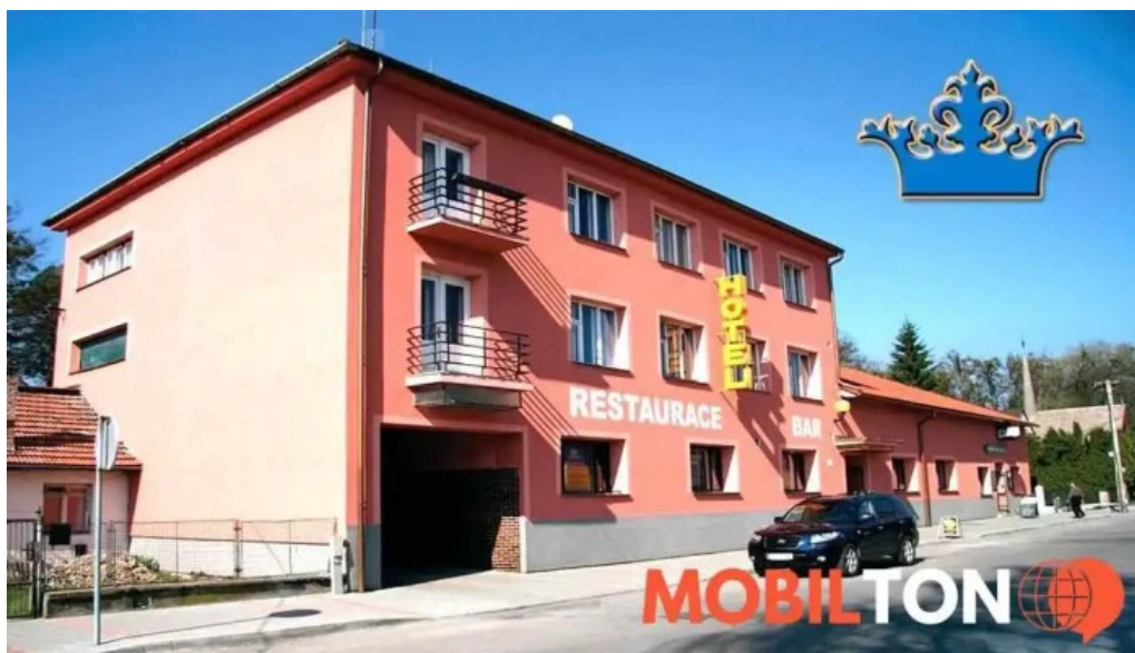
Hotel restaurace a pivnice koruna vse
