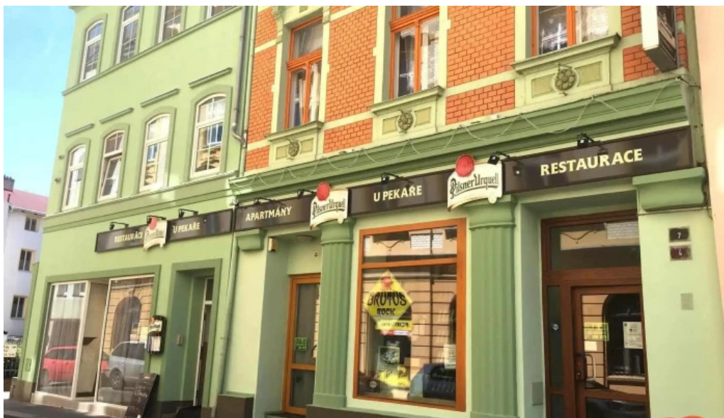
Ubytování u pekare decin vse
