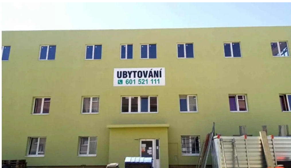
Ubytovna rakovník exteriér
